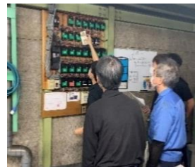
ポンプのスイッチを切り(左)、ホースを交換(右)
