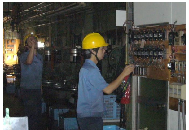
停電時を想定し、懐中電灯で配管を照らして確認
