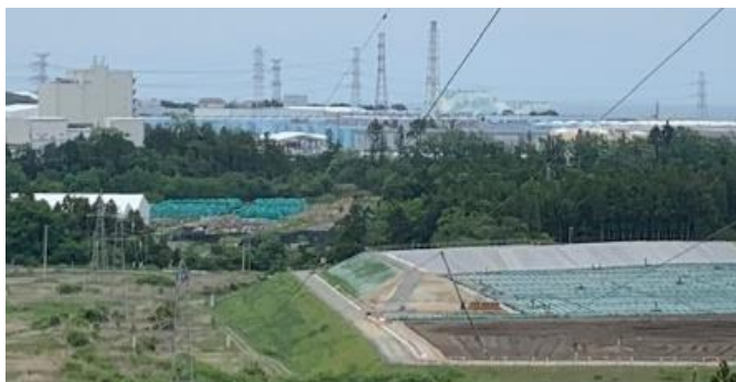
中間処理施設の土壌貯蔵現場の様子(小さく見えるがシートがかかった部分の高さは15m。遠くに福島第一原子力発電所が見える)
